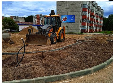
Подрядчиком ООО "Сервисная Дорожная Компания" выполнены работы по демонтажу фундамента, также проведена планировка территории, на которой устанавливается бордюрный камень. На подготовительных этапах в траншее выложена труба для дальнейшей прокладки электрического кабеля, установки и подключения светильников.
